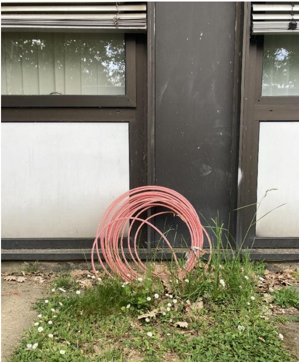
Kein seltener Anblick: Seit Monaten schon endet an der Eichendorffschule in Kelkheim das Rohr für die Glasfaserleitung vor dem Gebäude.
